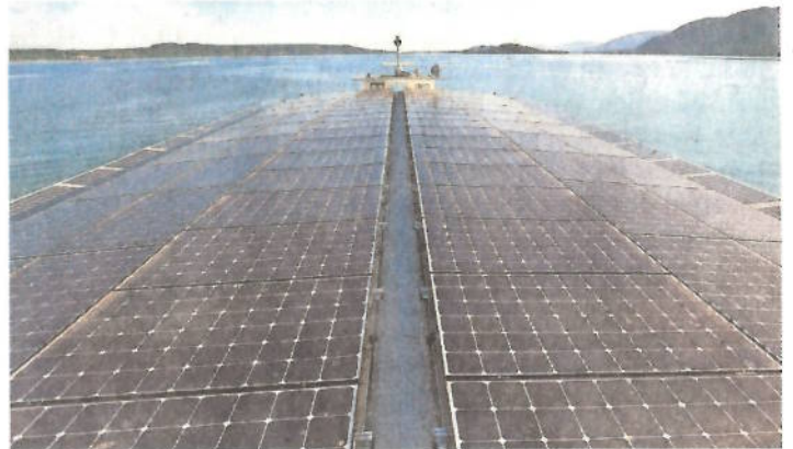
Das «MobiCat»-Dach ist ebenso ein eigenständiges «Kraftwerk», ...
