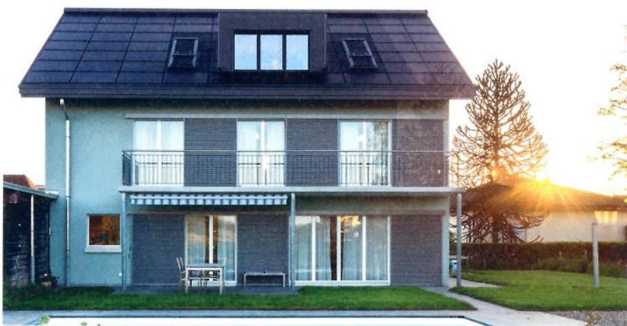
1 Die vorbildlich integrierte PV-Dachanlage versorgt Haus und Auto mit CO 2 -freiem Solarstrom
